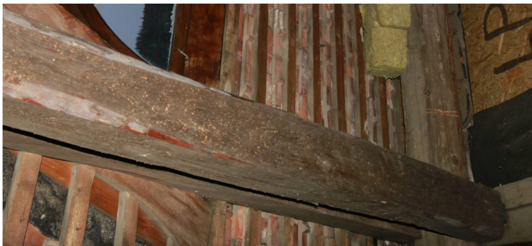
Obr. 3: oblast I. povrchové napadení tesaříkem ( Hylotrupes )
