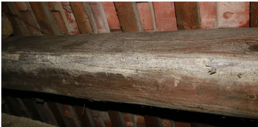
Obr. 6: ukázka povrchového napadení plísní
