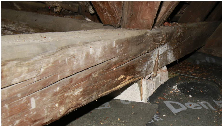
Obr. 4: oblast II. povrchové napadení tesaříkem (Hylotrupes)
