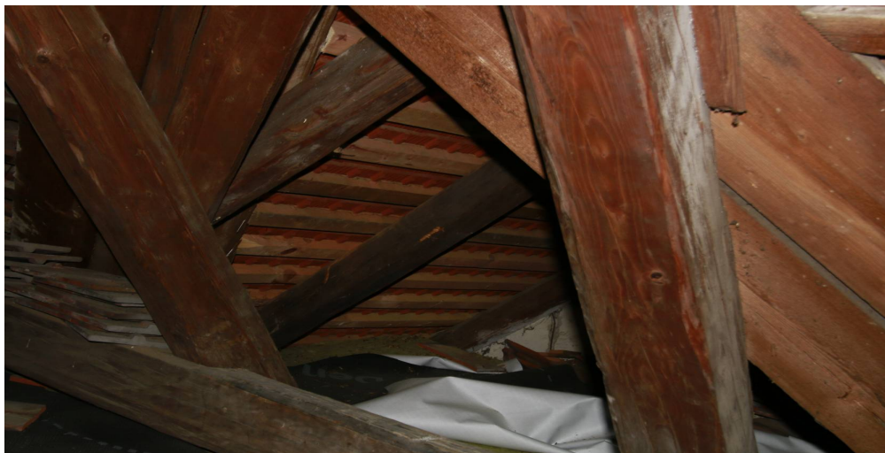
Obr. 5: oblast III. povrchové napadení tesaříkem (Hylotrupes)
